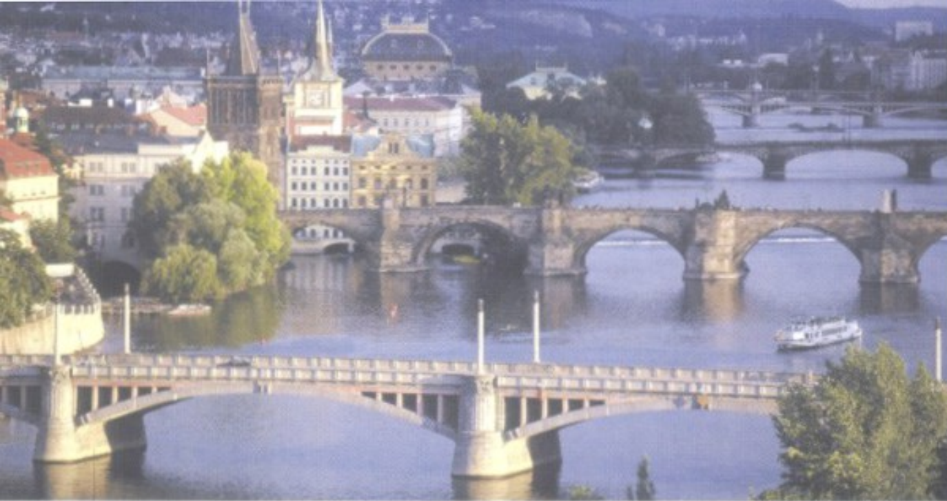
Eine Flusslandschaft wie im Bilderbuch: die Moldaubrücken. Links im Hintergrund: Altstädter Brückenturm und Nationaltheater.
